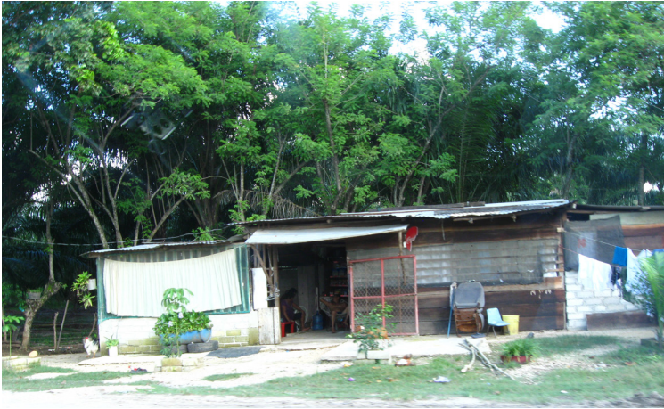
Foto: Casas de cemento a la orilla del paso del tren, Pakal Na, Palenque. Octubre 2019
