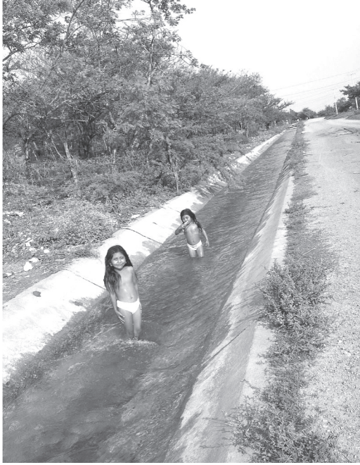
Canal de riego, Nueva Libertad, 2005.
